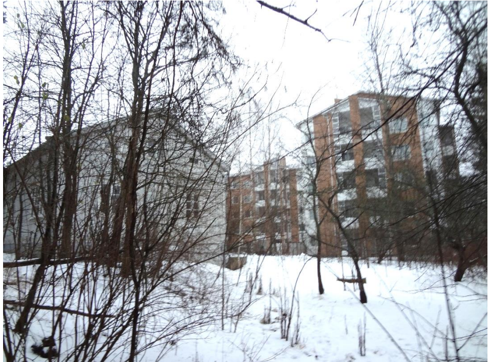
Kuvat: Yli-Jussila sijaitsee puistossa, pienellä kumpareella kerrostaloalueiden keskellä. Yllä näkymä tontin 5 suunnasta ja alla etelästä puiston suunnasta.
